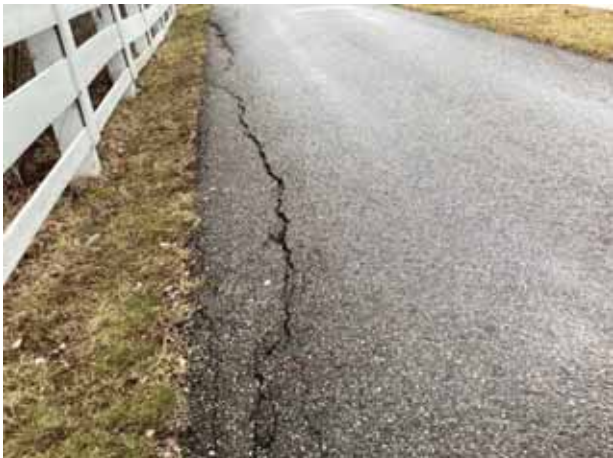
Edge cracks
